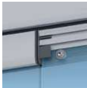
SUJECIÓN DEL VIDRIO MEDIANTE TORNILLOS
